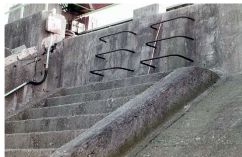
図9 地盤沈下の様子(鍋田川境水門)
